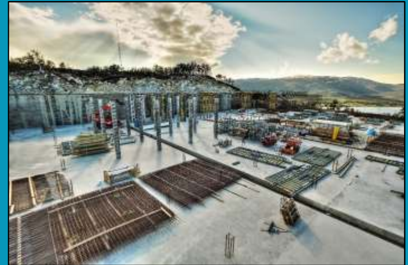
Tromsø Kommune - Nord-Tromsøya Høydebasseng
