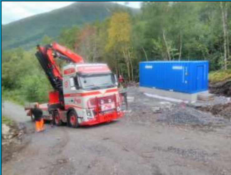
Vartdal Vassverk – Vannbehandlingsanlegg 400m 3 /h
