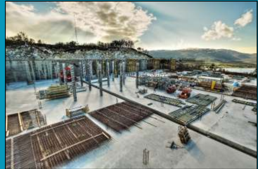
Tromsø Kommune - Nord-Tromsøya Høydebasseng
